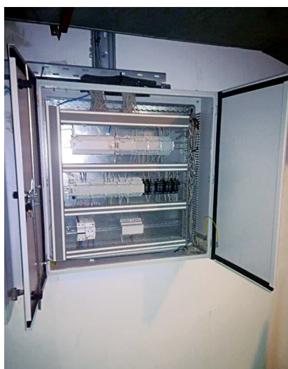
Εγκατάσταση BMS σε λεβητοστάσια και αντλίες θερμότητας στο κτήριο Λιμενικών Έργων
