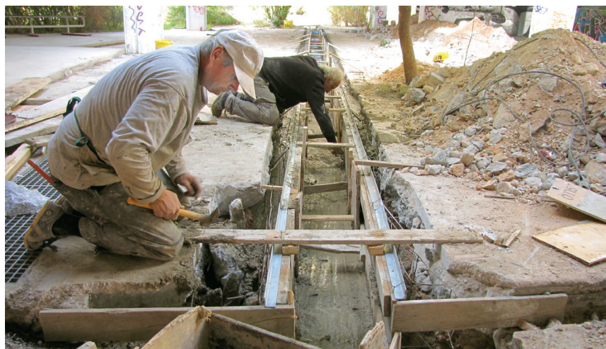
Έργο αποκατάστασης δικτύων ύδρευσης - αποχέτευσης Πολυτεχνειούπολης
