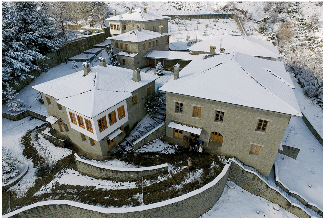
Μετσόβιο Κέντρο Διεπιστημονικής Έρευνας
