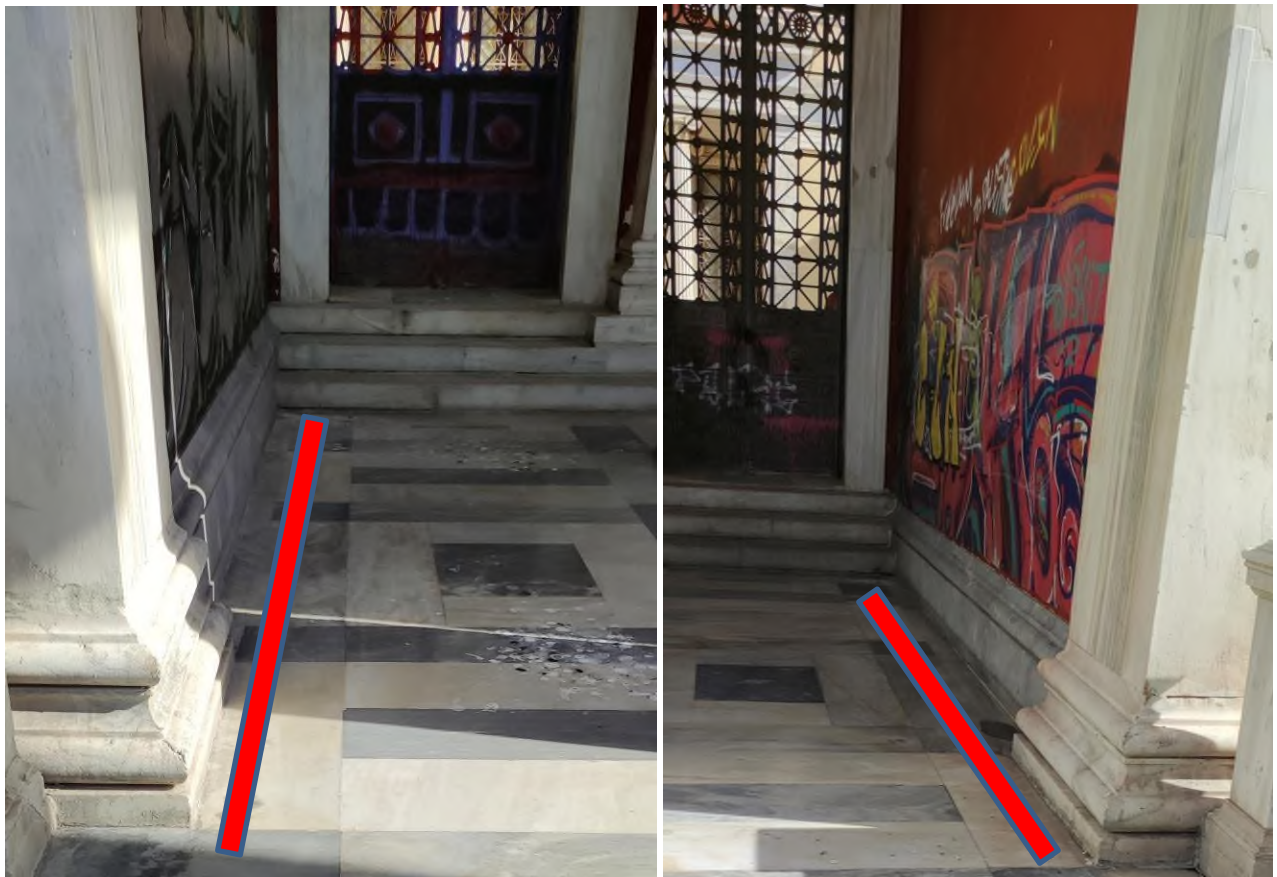
Εικόνα 4 Σημεία τοποθέτησης νέων φωτιστικών σωμάτων.
