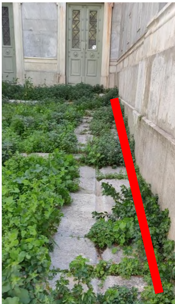
Εικόνα 3 Σημείο τοποθέτησης νέων φωτιστικών σωμάτων.
