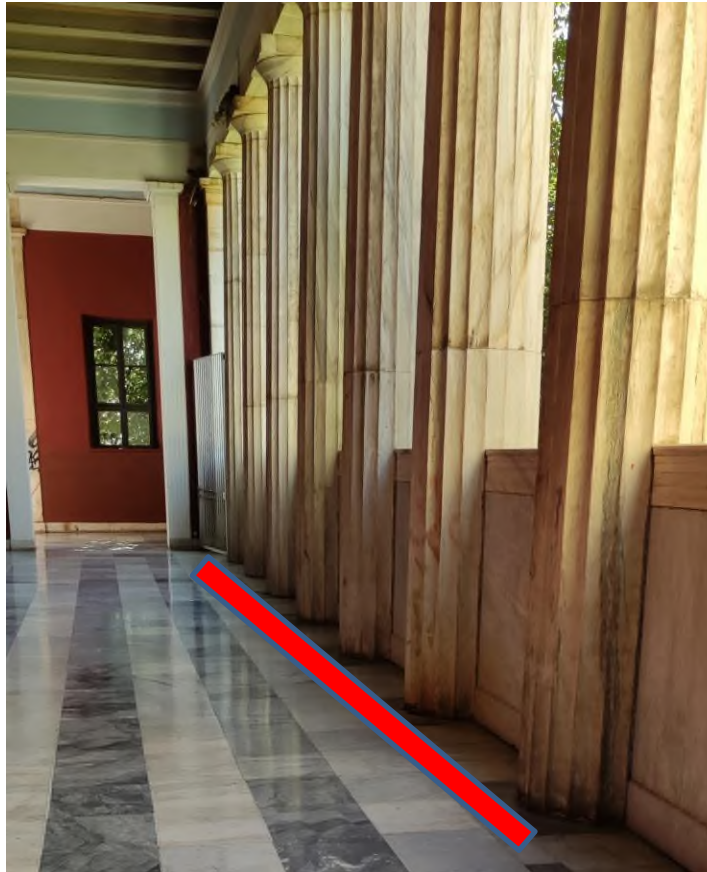
Εικόνα 2 Σημείο τοποθέτησης νέων φωτιστικών σωμάτων.
