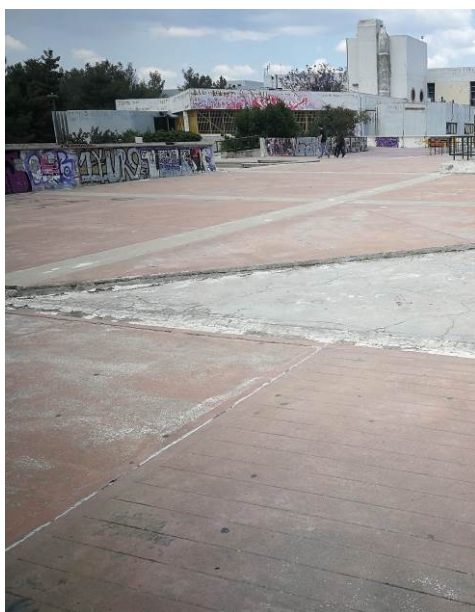
Εικόνες 3.3.1, 3.3.2: Πλήρωση κενών δαπέδων με τσιμεντοκονία.
