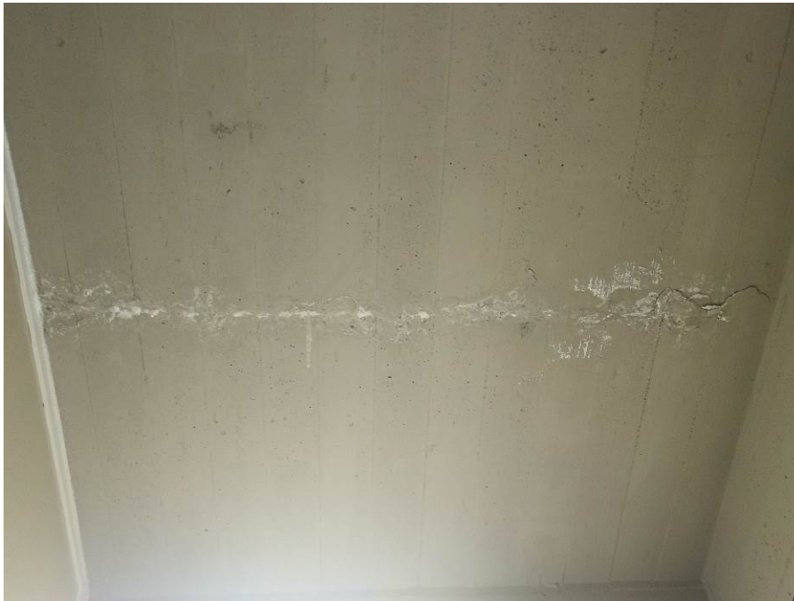
Εικόνα 6.2: Οροφή διαδρόμου ΚΕΔ-Α με εμφανή τη ρωγμή
