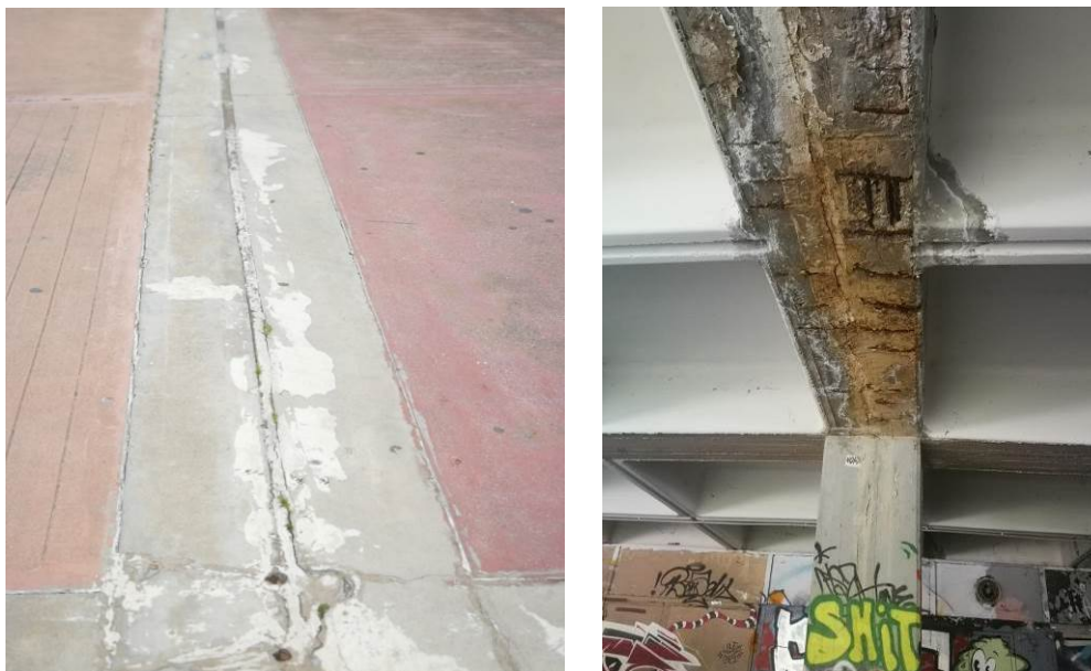
Εικόνα 5.2.1, 5.2.2: Αρμός άνω και κάτω επιφάνεια
