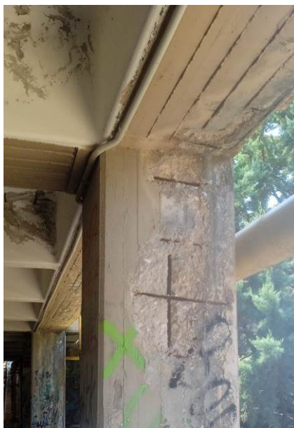
Εικόνα 4.2.1: Αποκατάσταση βλαβών σκυροδέματος με επισκευαστικό κονίαμα τύπου R4.
