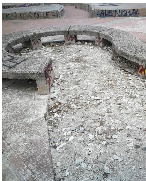
Εικόνες 3.3.1, 3.3.2: Πλήρωση κενών δαπέδων με τσιμεντοκονία.
