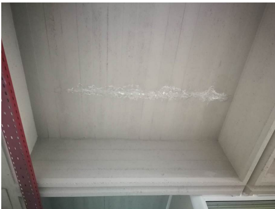
Εικόνα 6.1: Οροφή διαδρόμου ΚΕΔ-Α με εμφανή τη ρωγμή
