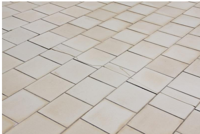
Εικόνα 2 Φθορές στην πλακόστρωση – Ανατολικά
