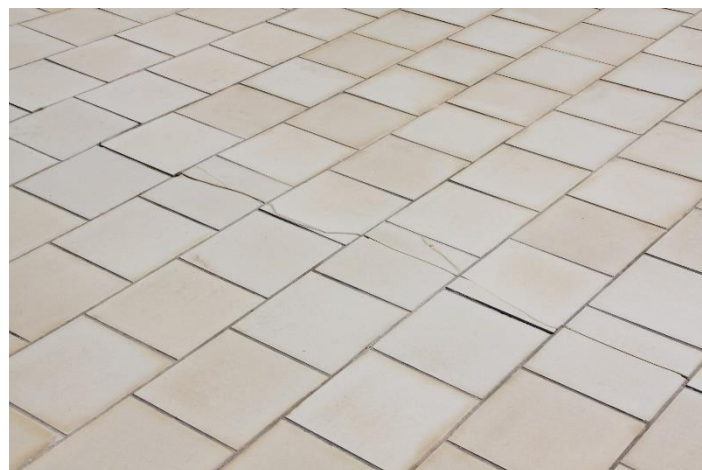
Εικόνα 24 Φθορές στην πλακόστρωση – Ανατολικά
