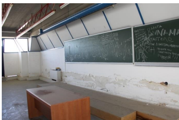
Εικόνα 13 Φθορές σοβά στο κάτω μέρος των τοίχων
