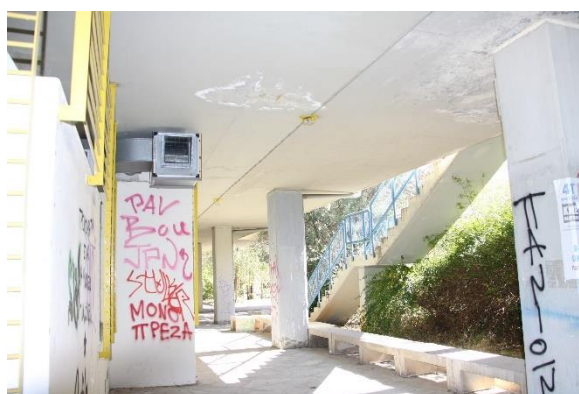
Εικόνα 12 Φθορές στην πλάκα οπλ. σκυροδέματος
