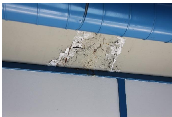
Εικόνα 14 Φθορές στην πλάκα οπλ. σκυροδέματος
