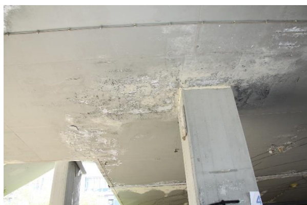
Εικόνα 11 Φθορές στην πλάκα οπλ. σκυροδέματος
