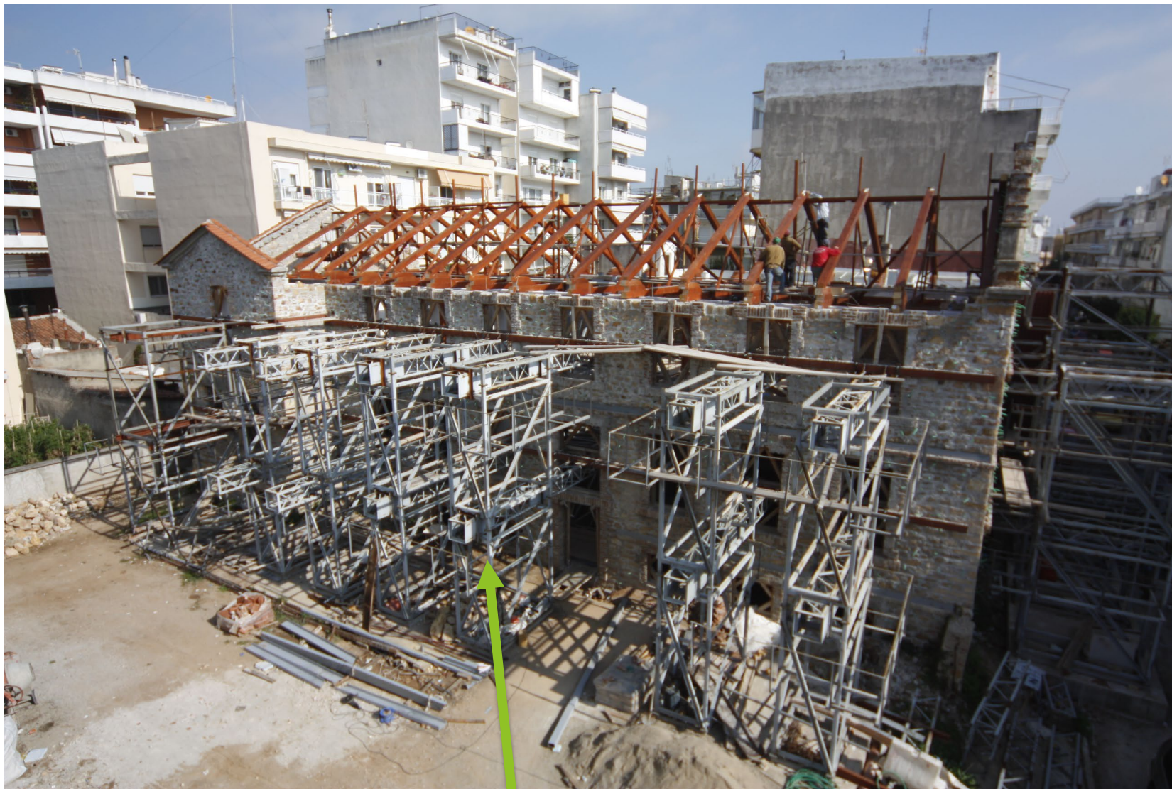
Δικτύωμα στήριξης στο Διατηρητέο Κτίριο Καπνομάγαζου Αλεξανδρούπολης
